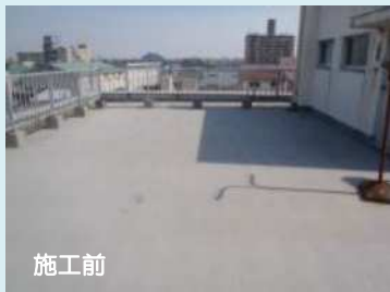
（防水工事） シームレス工法
