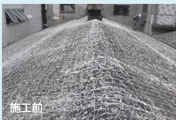
（二重屋根工事） リリーフ工法
